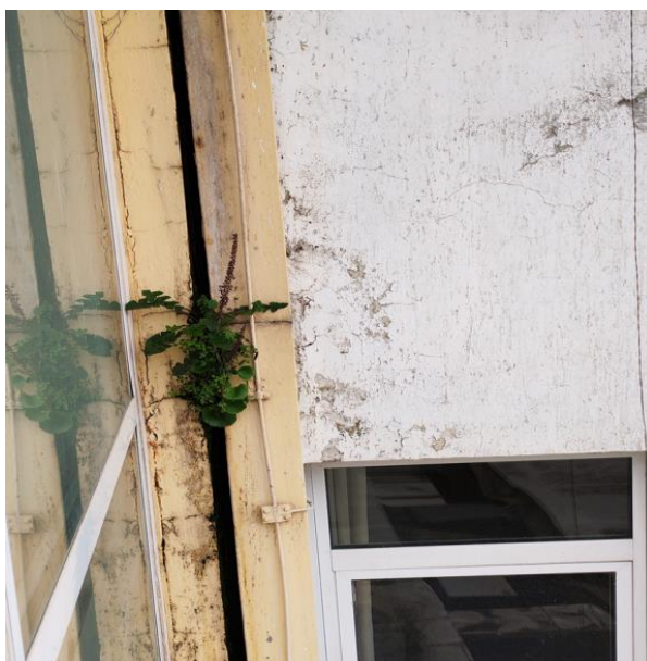
Φωτο (3): Αποσαθρώσεις παράπλευρων επιφανειών
