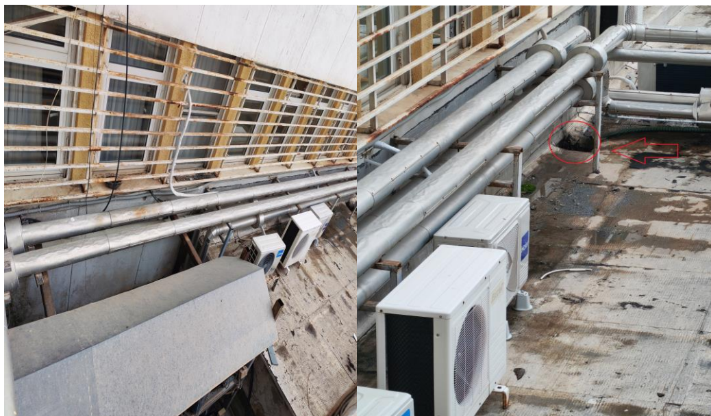
Φώτο (4): Όδευση νέας υδρορροής στην τελική στάθμη
