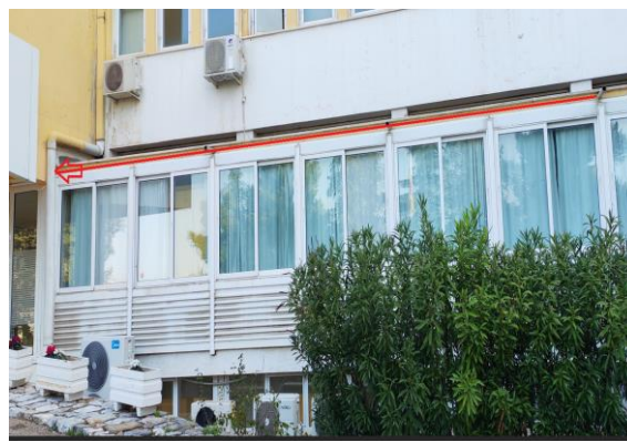
Φώτο (8): Σύνδεση (3) υδρορροών στεγάστρου
