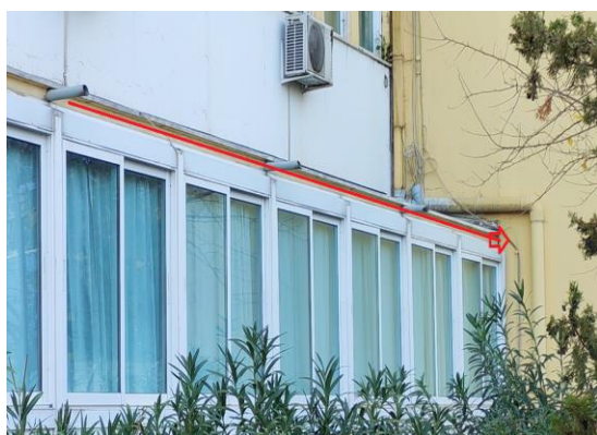
Φώτο (7): Σύνδεση (3) υδρορροών στεγάστρου
